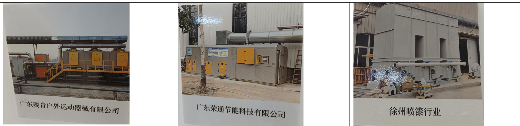
图 4. 企业总公司干式过滤器+吸附浓缩+RCO 工程案例展示
