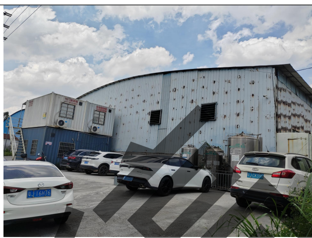
项目南面：机械设备制造厂
