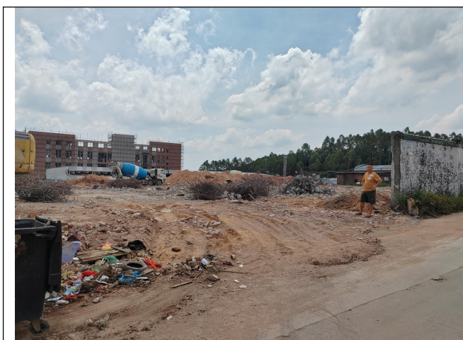
项目东面：施工工地
