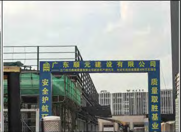
项目西南面：江门市川南减震器有限公司（在建）
